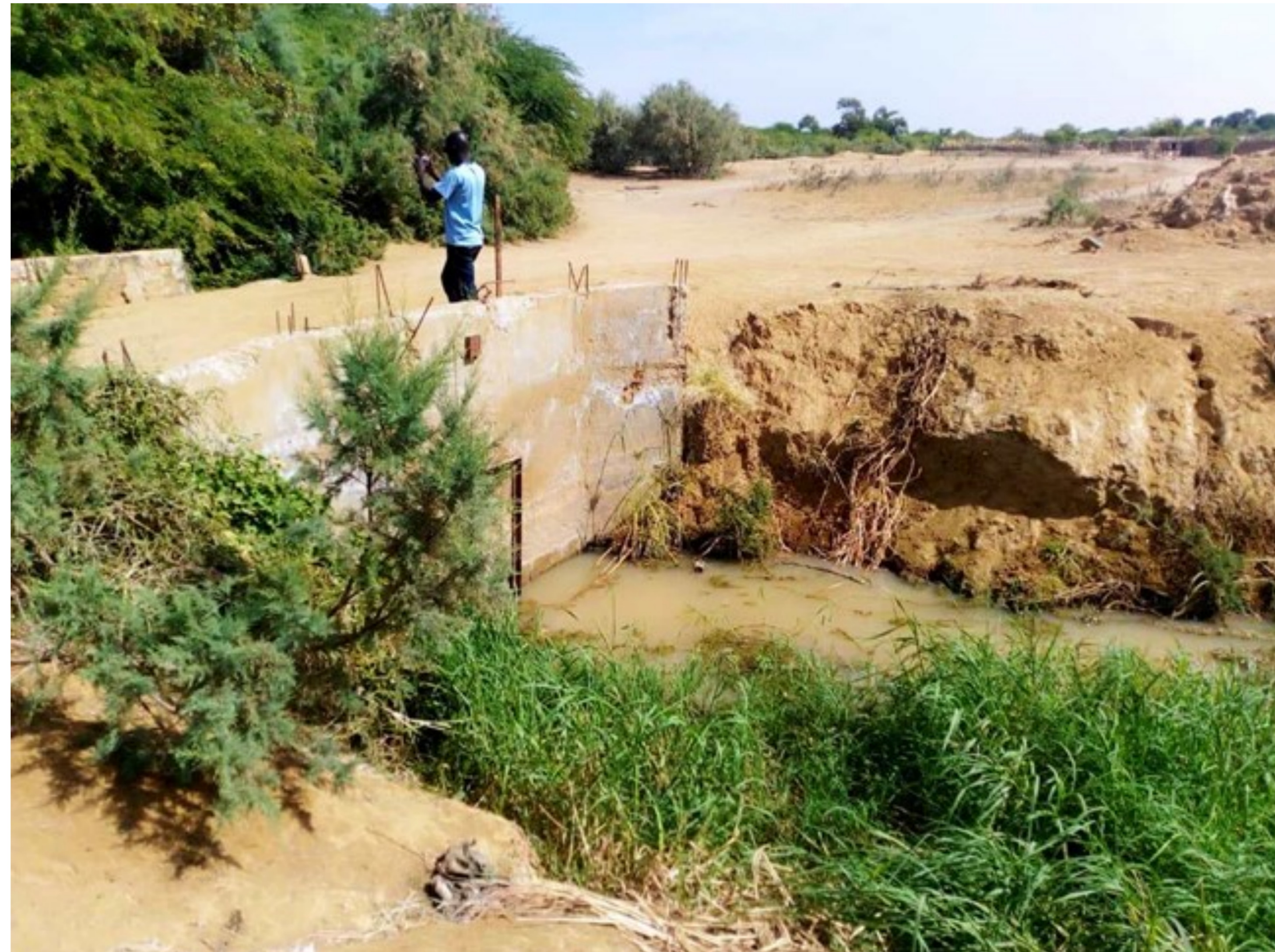
Aménagements d'un canal en amont et en aval de la mare
