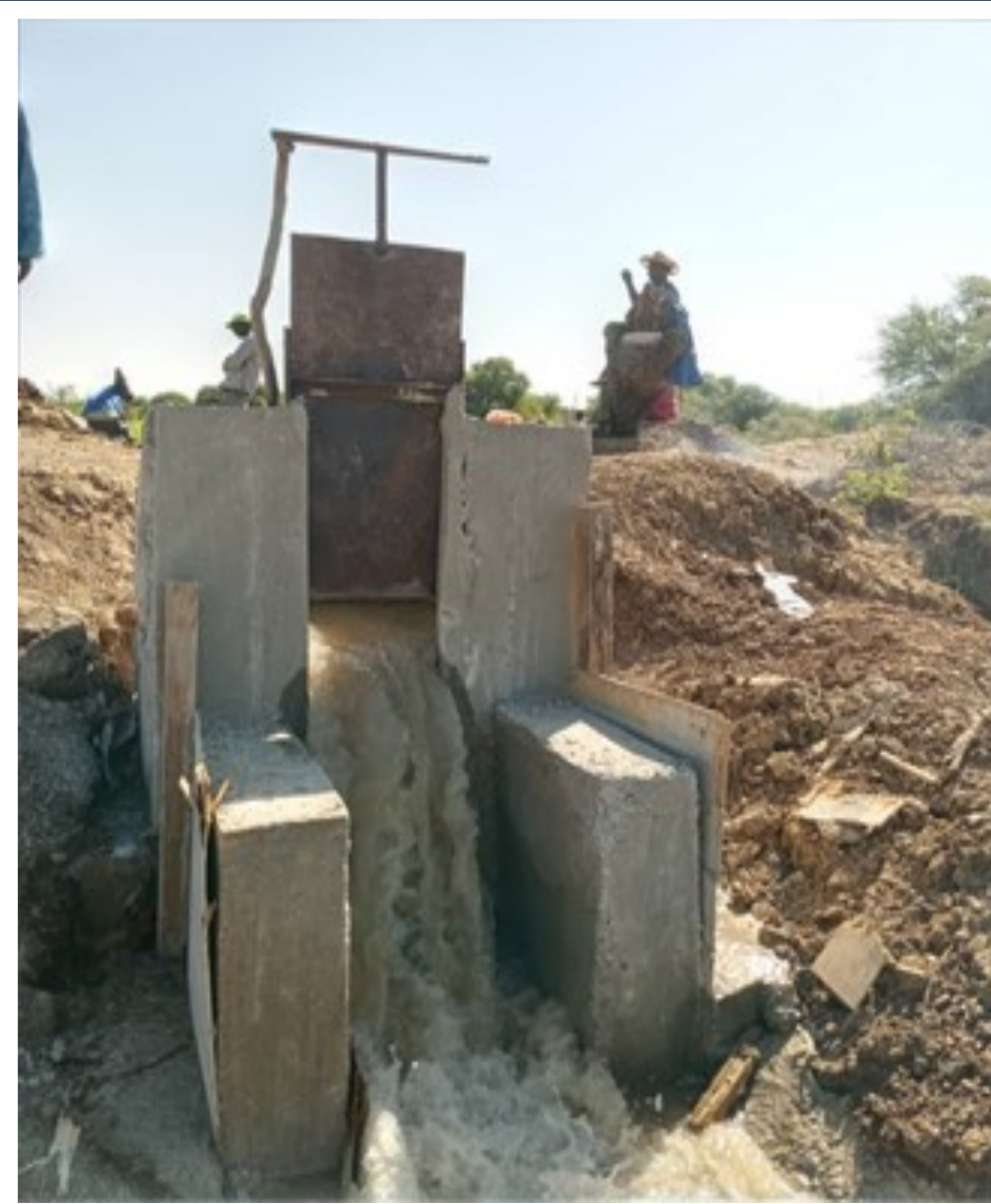
construction du Dalot
